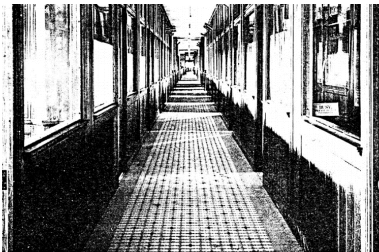
Figura 27 - Corredor de um edifício de escritórios da década de 1890. Fonte: GATTER, 1982.
