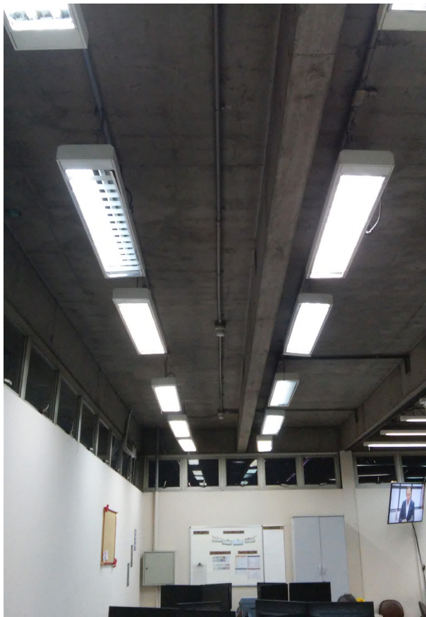
Figura 62 - Luminárias instaladas no espaço de tarefas administrativas e de controle. Estas luminárias são diferentes do espaço onde trabalham os teleoperadores, já que as dimensões são diferentes, cada luminária abriga duas lâmpadas e há aletas para o controle do ofuscamento direto. Fonte: autora.
